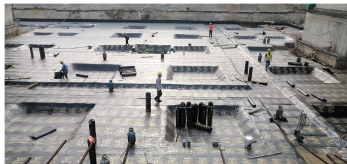
沧州项目施工现场
